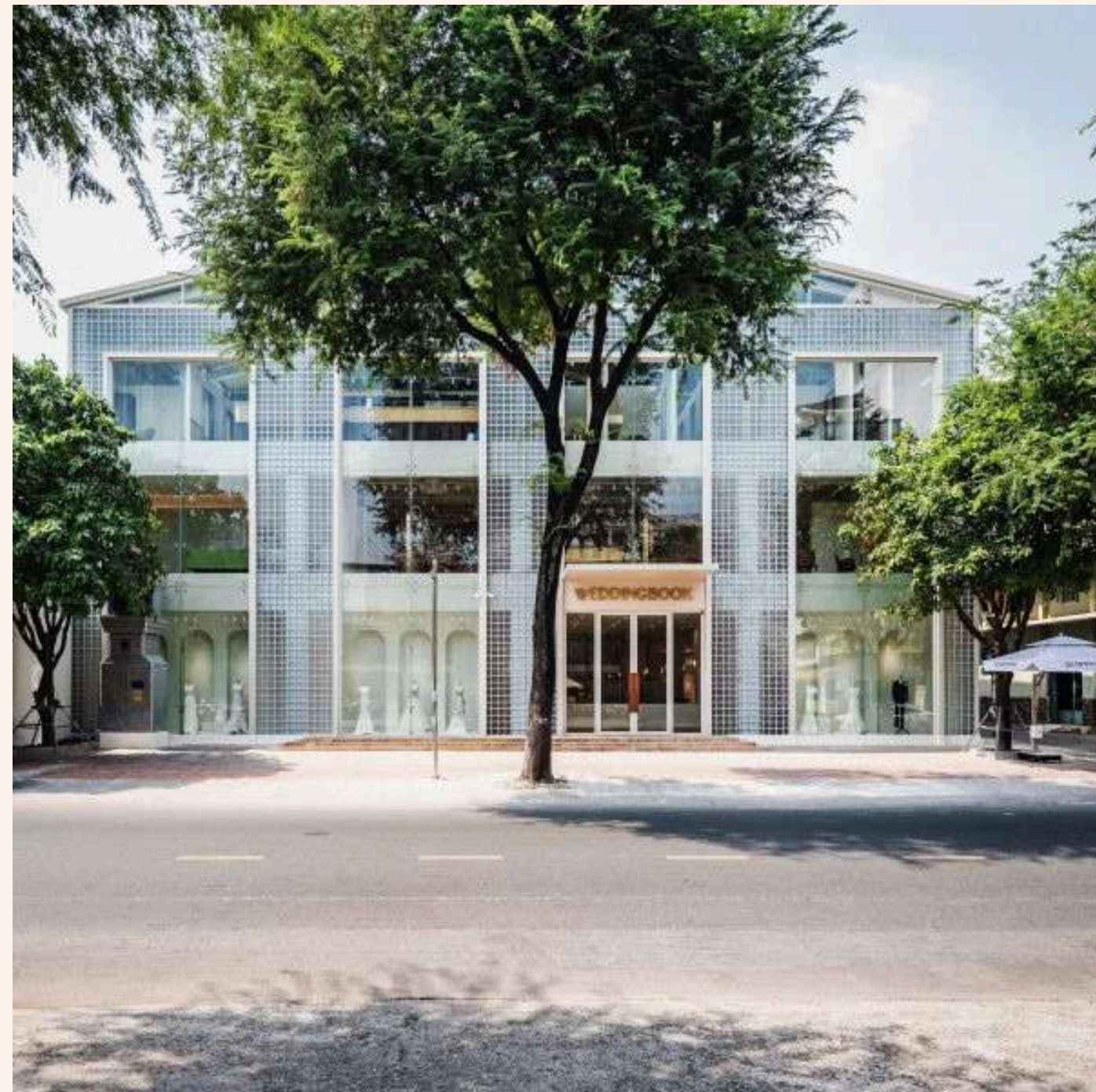
NHÀ HÀNG TIỆC CƯỚI WEDDINGBOOK QUẬN 10 Cung cấp và lắp đặt sàn gỗ nhựa ngoài trời cho khu chụp hình. Số lượng 375m 2
