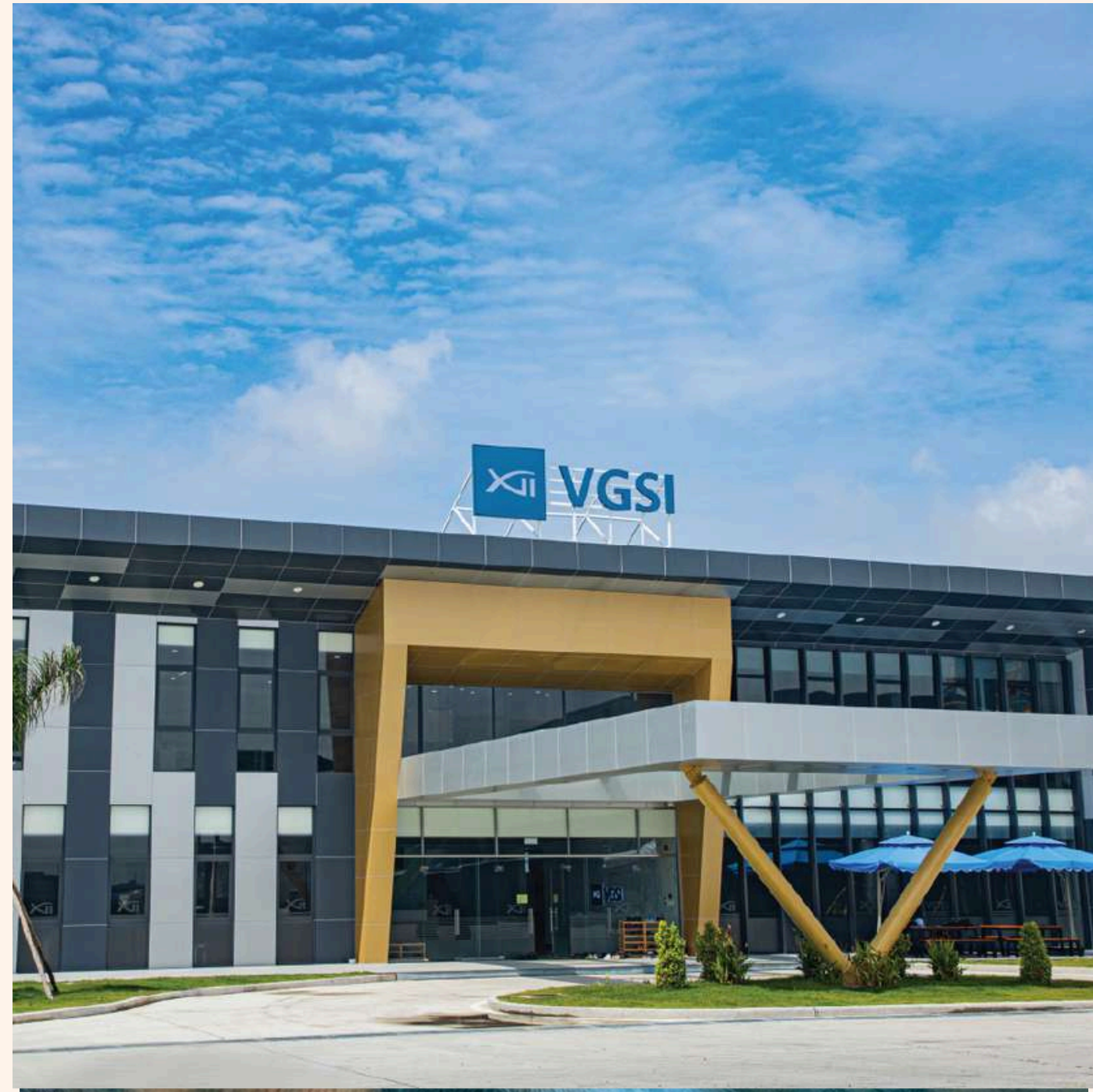
NHÀ MÁY THANG MÁY KOREA - KCN NHƠN TRẠCH 5 Cung cấp và lắp đặt sàn vinyl cho khối văn phòng làm việc Số lượng 2200m 2
